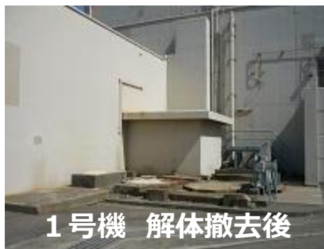
〈原子炉格納容器窒素供給装置の撤去の状況〉
