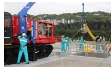
取水ポンプ車操作訓練
