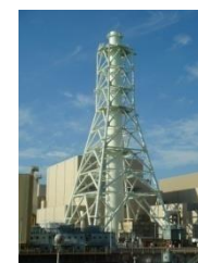
排気筒改造工事
