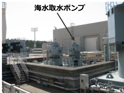
防水壁設置前 (4号機)
