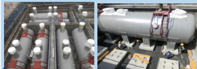
【地下燃料タンク外観】 (埋戻し前の工事中写真)
