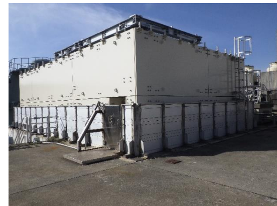
防水壁(1.5m)設置および竜巻対策後
