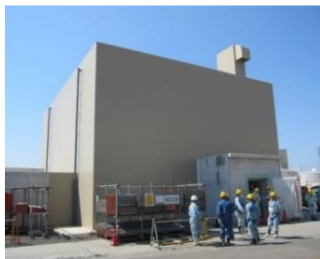
EWSポンプ室（3号機） 防水構造
