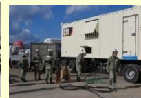
電源車操作訓練
