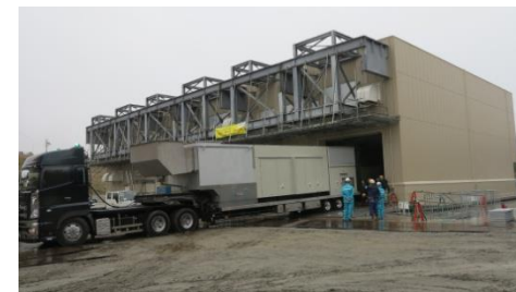
ガスタービン発電機
