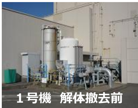
〈原子炉格納容器窒素供給装置の撤去の状況〉
