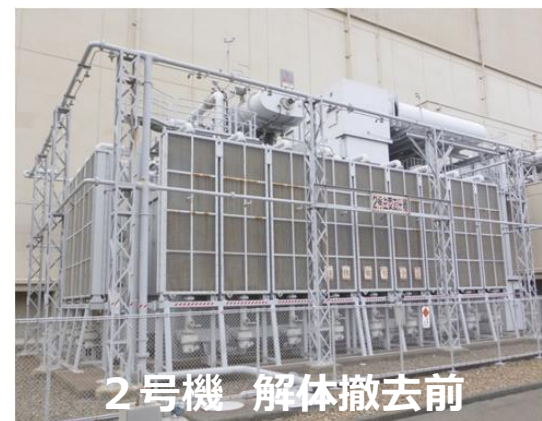
〈変圧器の撤去の状況〉
