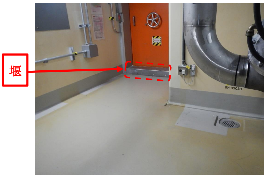
図 4-1 漏えい油の拡大の防止対策の例
