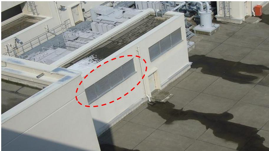
図 7-3 中央制御室換気空調系の外気取入口
