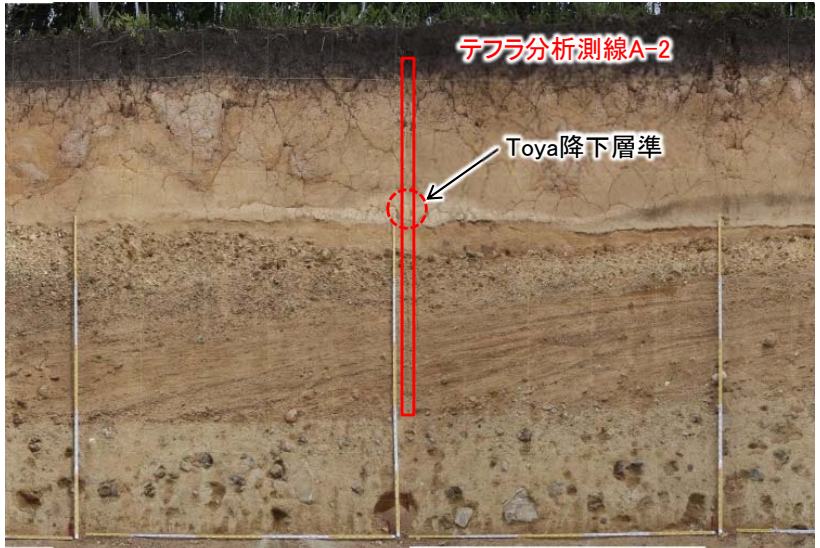
法面④詳細画像
