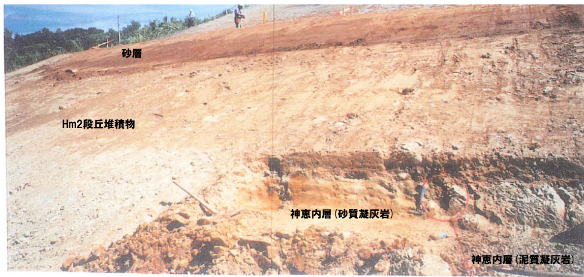
全景写真(敷地造成工事時確認箇所)
