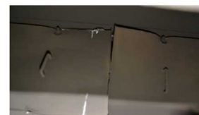
盤内仕切板の状態 (母線室-遮断器室間)
