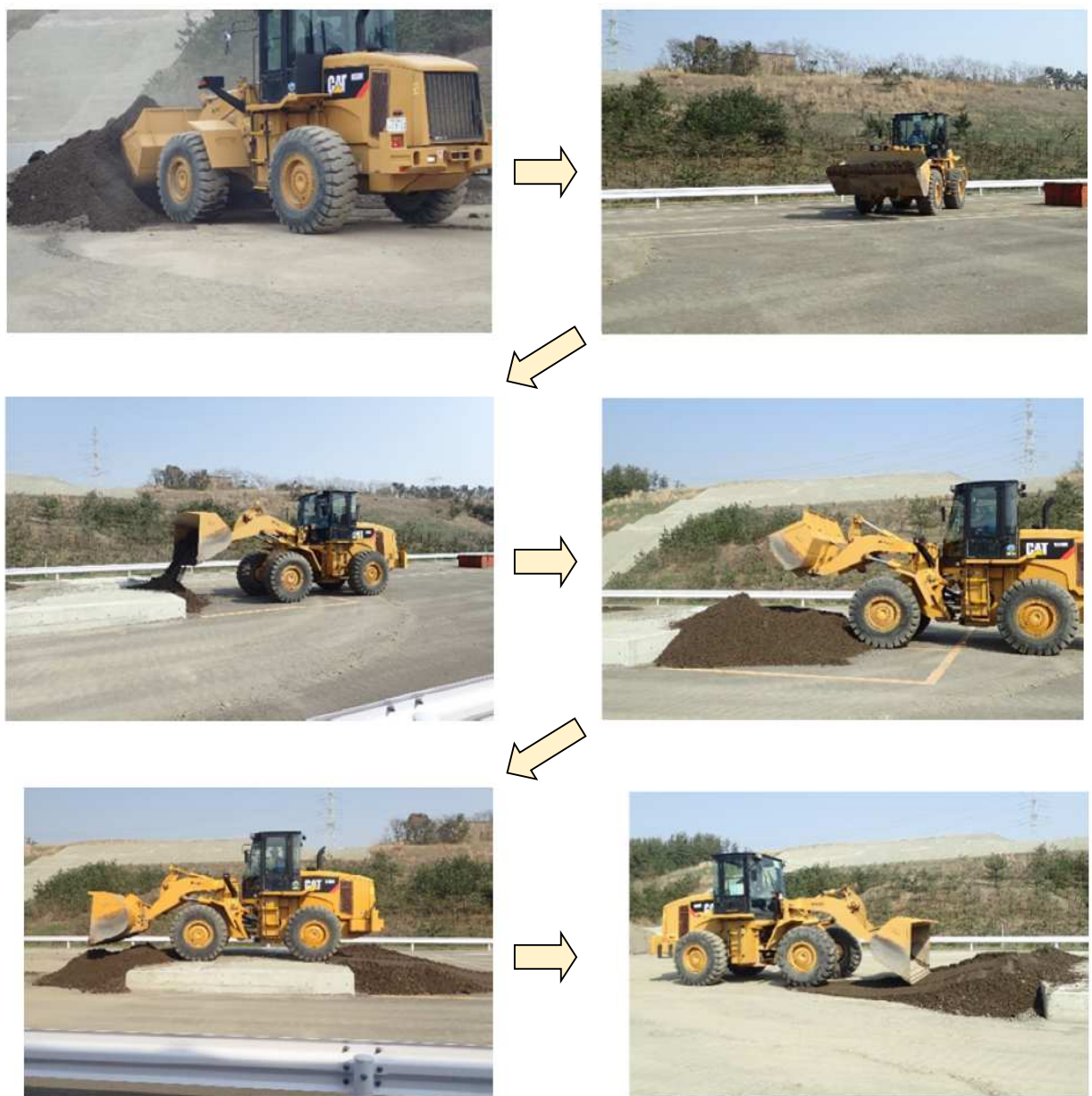
図 12-8 約 50cm の段差の仮復旧 (3)
