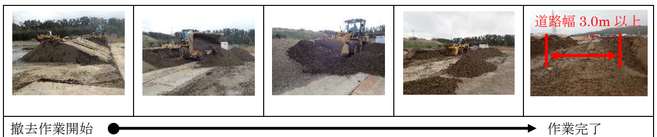
図 12-2 土砂撤去状況
