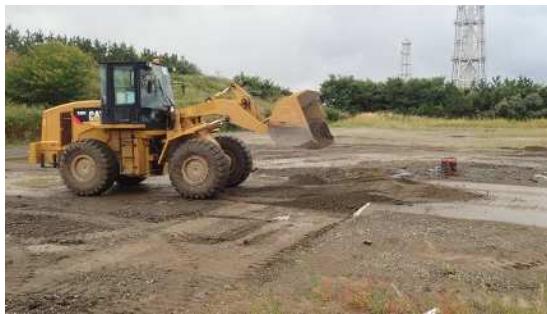
段差復旧状況③
