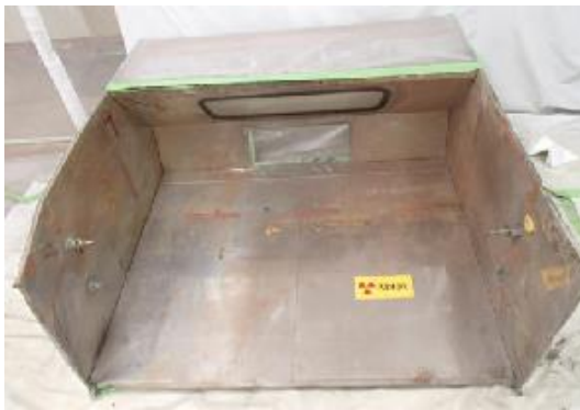
ドラフト内張り剥離前
