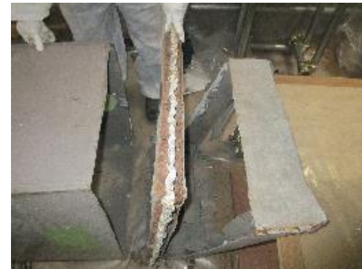
フランジ切り離し（フランジは直接 測定困難につきドラム缶へ封入）
