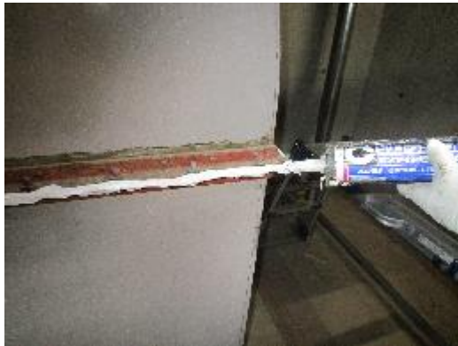
縦排気管フランジ部 コーキング材塗布
