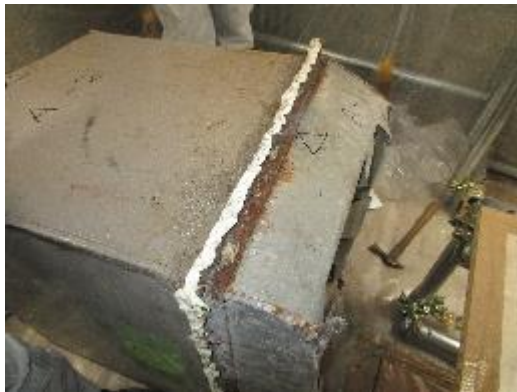
縦排気管切り離し
