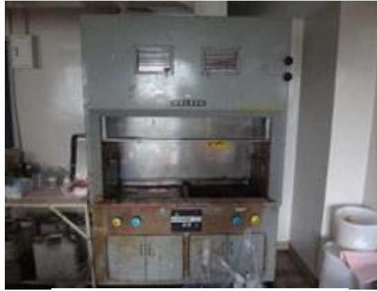
ドラフトチャンバー解体前
