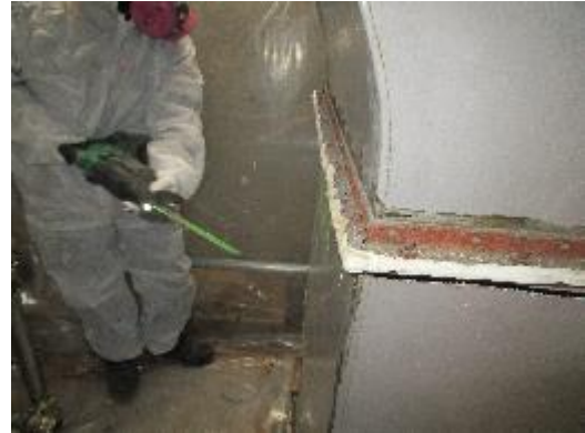
縦排気管フランジ部切断
