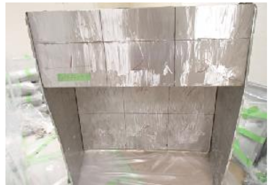
ドラフト内張り剥離後
