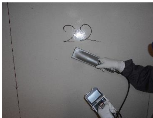
直接法による壁の測定
