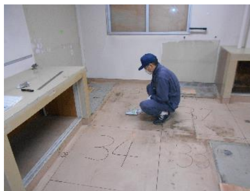
直接法によるリノリウム床の測定
