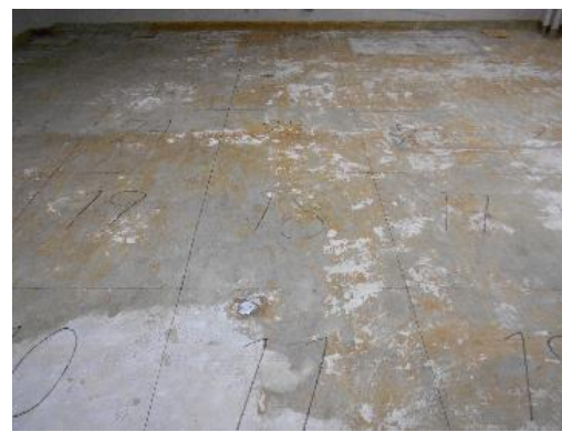
リノリウム撤去後のコンクリート床の区分線ケガキ
