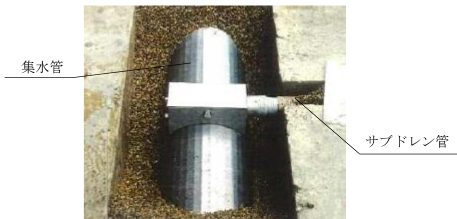
第 3-15 図 集水管敷設状況
