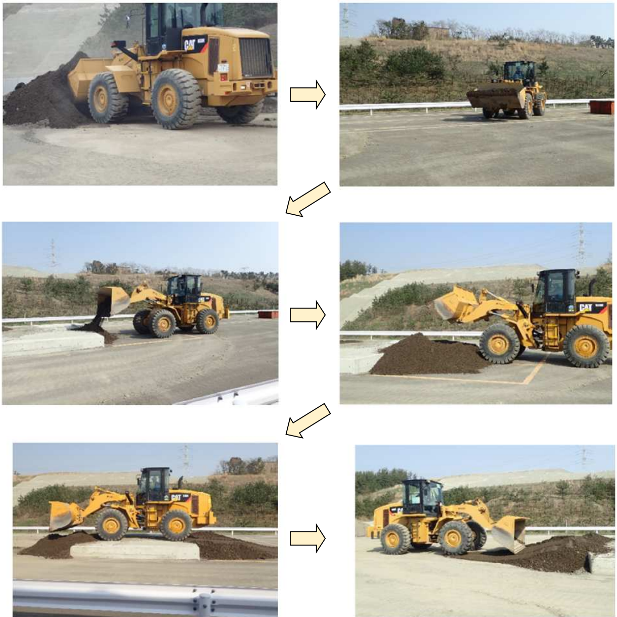
図 12-8 約 50cm の段差の仮復旧 (3)
