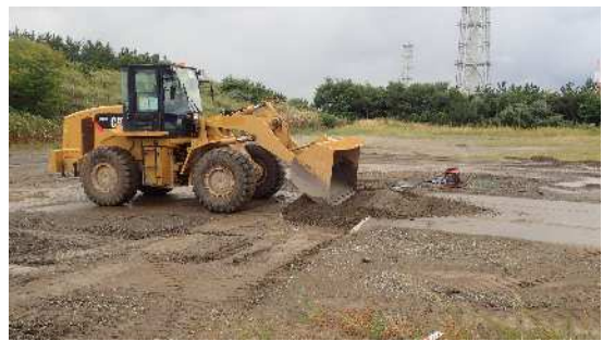
段差復旧状況②
