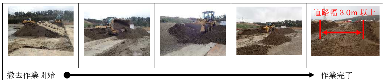
図 12-2 土砂撤去状況
