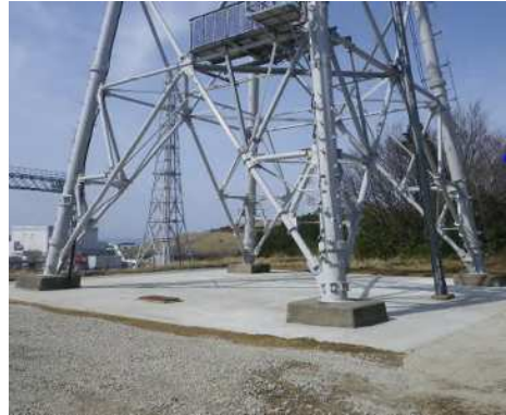
(500kV 南新潟幹線 No. 1 送電鉄塔)
