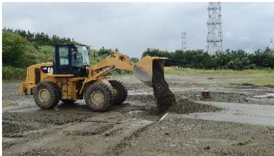
段差復旧状況①
