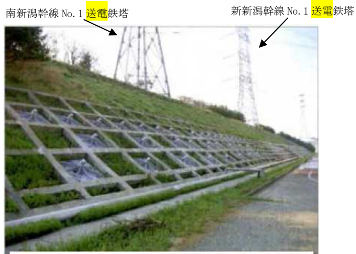
図 1-6 500kV 新新潟幹線及び 500kV 南新潟幹線 No. 1 送電鉄塔下側の法面の補強状況写真
