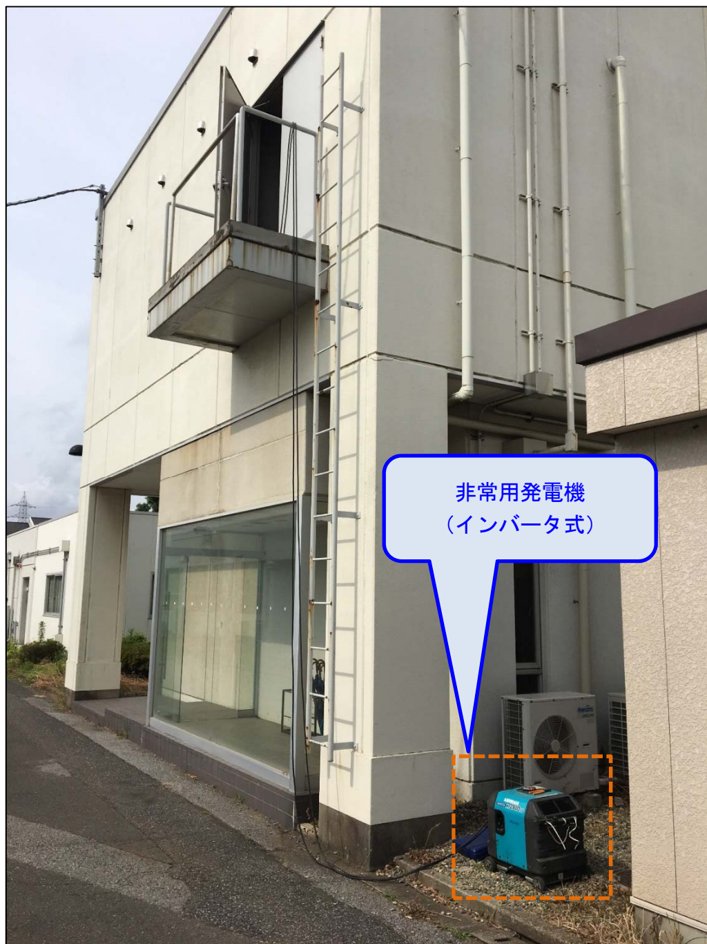
図8 モニタリングポストデータオンライン収集システムを発電機等で運用した時の様子
