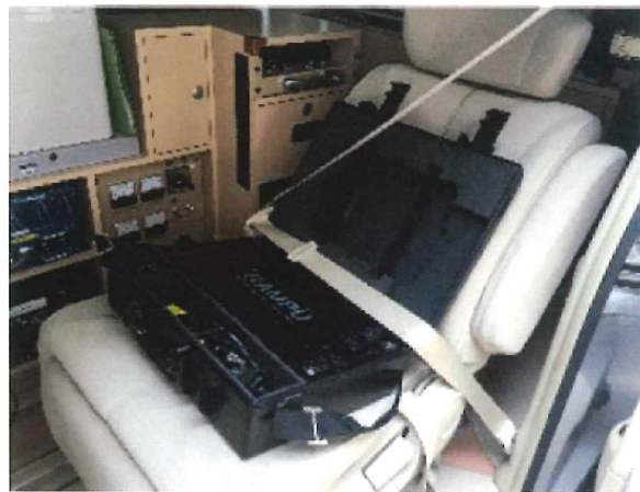
図 6.2.46 RAMPU 本体の設置の様子
