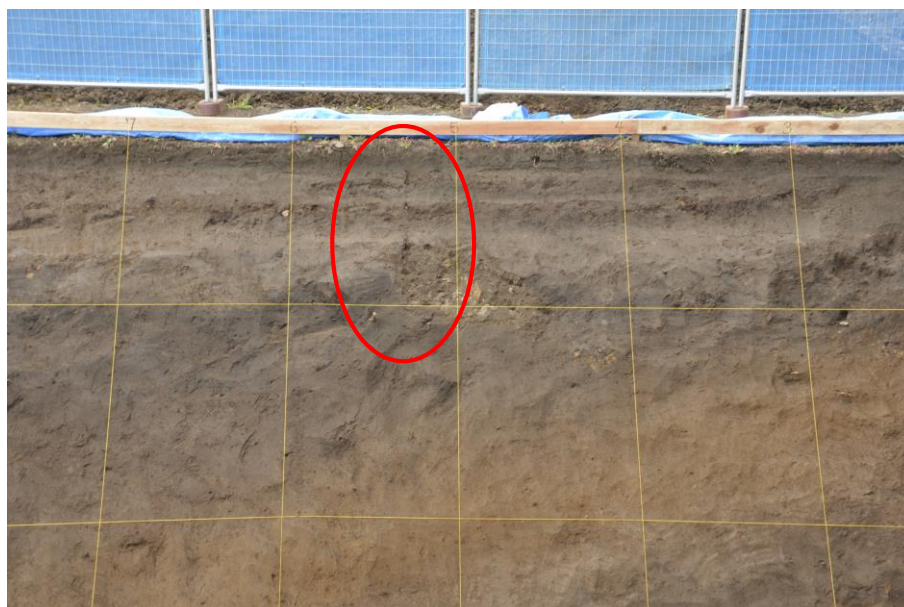
図 2-33 耕作土層まで切る開口亀裂
