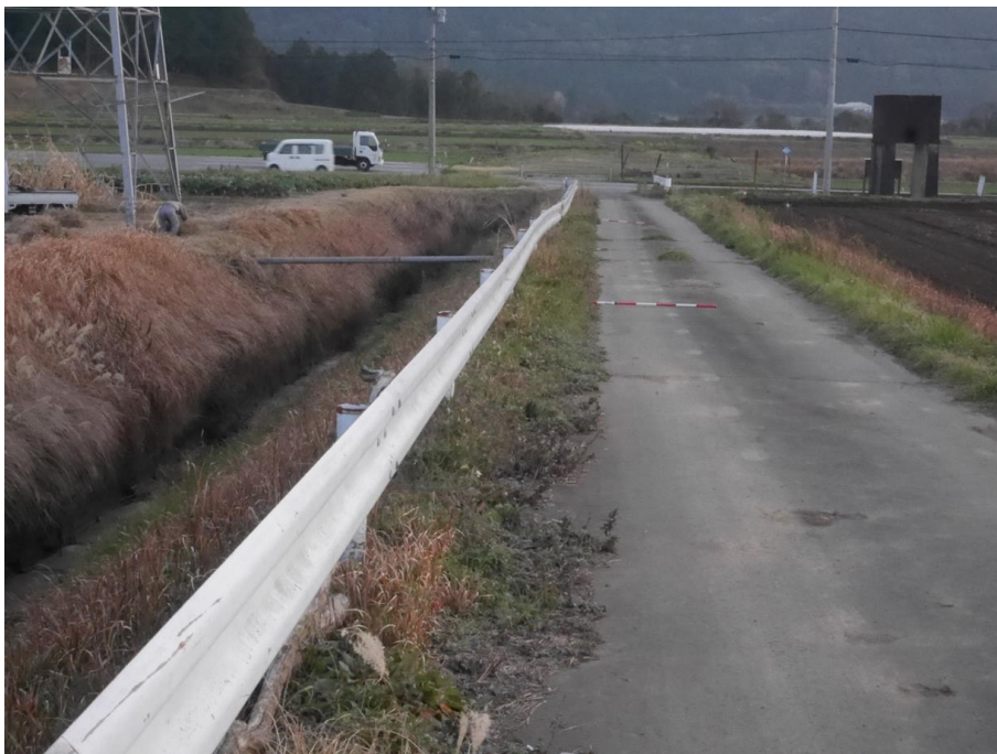
図 2-12 陣内トレンチ周辺の状況 Loc.2 (右横ずれ約 20cm)
