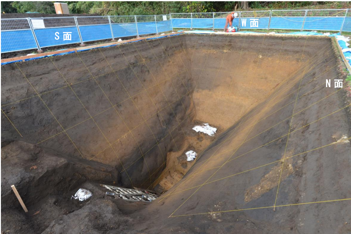
図 2-23 トレンチ全景 (北東側より撮影)
