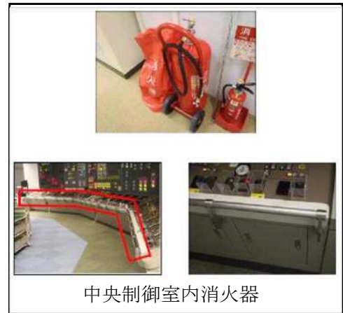
図 1-1 中央制御室における消火器及び手すりの状況
