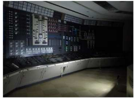
図 1-3 中央制御室シミュレーション施設における可搬型蓄電池内蔵型照明確認状況
