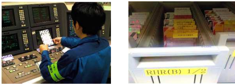
図2-29 中央制御室におけるタグ札運用
