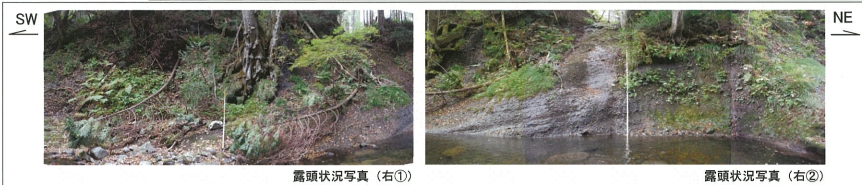
第3.3-59図(2) 六ヶ所村老部川 (南) 上流部の露頭状況図 (リニアメント北方延長部)
