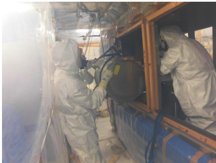
図 8.2-17 貯槽の取り出し作業の様子
