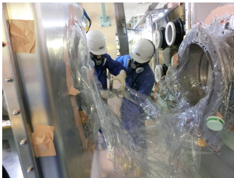
図 8.2-15 切り離し作業の様子
