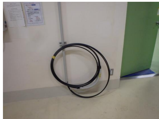
図 6.5-28 光ケーブル敷設後(実験準備室)
