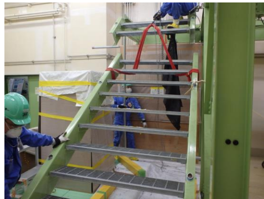
図 6.5-10 架台撤去（階段）
