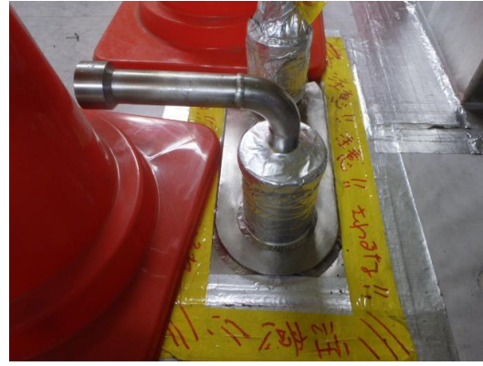
図 6.1-17 溶液燃料給排水系配管分離前及び分離後
