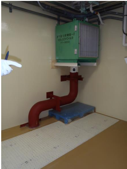
図 6.1-16 給気フィルタ撤去前及び撤去後
