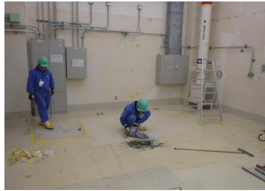
図 6.5-16 撤去後の清掃
