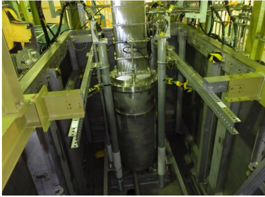
図 6.1-1 600φ 非均質炉心タンク撤去前及び撤去後
