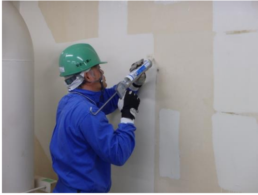
図 6.5-17 撤去後補修（壁）
