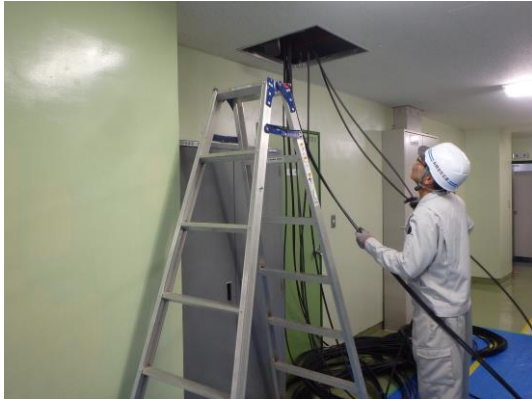
図 6.5-23 光ケーブル敷設（制御室前）
