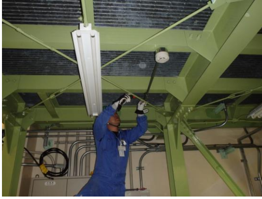
図 6.5-5 火災報知器撤去
