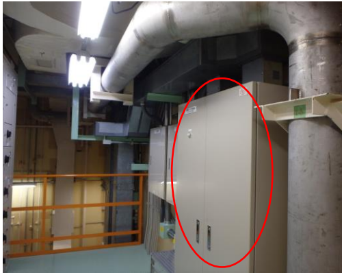
図 6.1-11 配管ヒータ分岐盤撤去前及び撤去後
