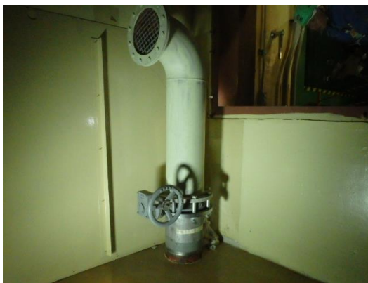
図 6.1-25 実験棟 A 建家換気空調装置（排気主ダクト）分離前及び分離後
