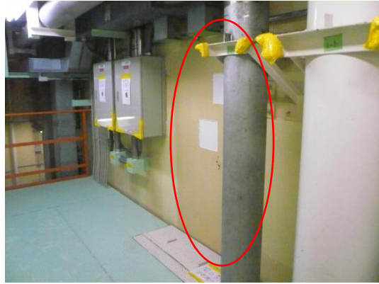
図 6.1-11 配管ヒータ分岐盤撤去前及び撤去後
