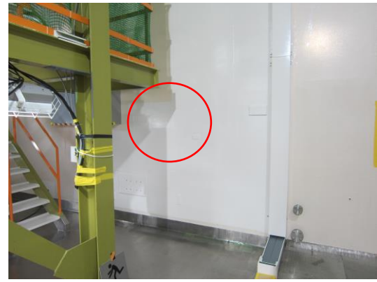
図 6.1-7 サーボ型液位計中継箱撤去前及び撤去後
