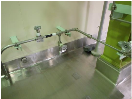
図 6.1-23 その他の設備（圧縮空気設備系統(ELA)）分離前及び分離後
