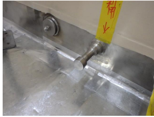
図 6.1-24 その他の設備（真空設備系統(HVN)）分離前及び分離後
