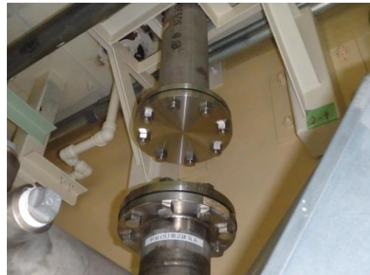
図 6.1-20 炉室(S)換気空調設備系統分離前及び分離後
