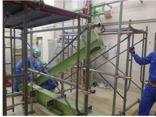
図 6.5-12 架台撤去
