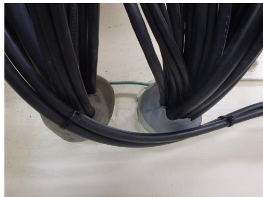
図 6.5-22 光ケーブル敷設（ネオシール）
