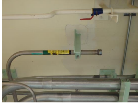
図 6.1-21 槽ベント設備 A 系統分離前及び分離後
