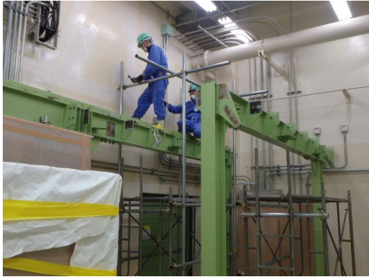
図 6.5-11 撤去用足場設置
