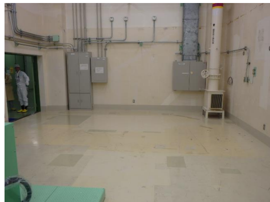
図 6.5-20 作業終了後（実験準備室）
