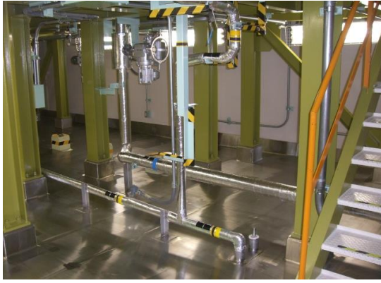
図 6.1-17 溶液燃料給排水系配管分離前及び分離後
