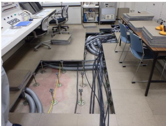
図 6.5-21 光ケーブル敷設（制御室）
