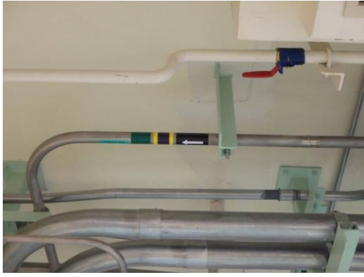
図 6.1-21 槽ベント設備 A 系統分離前及び分離後
