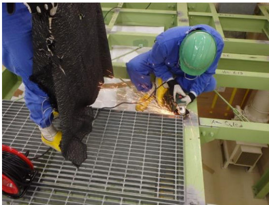
図 6.5-9 グレーチング撤去
