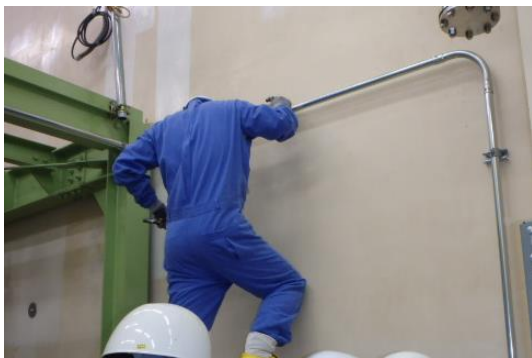
図 6.5-7 地震計ケーブルの移設（撤去中）
