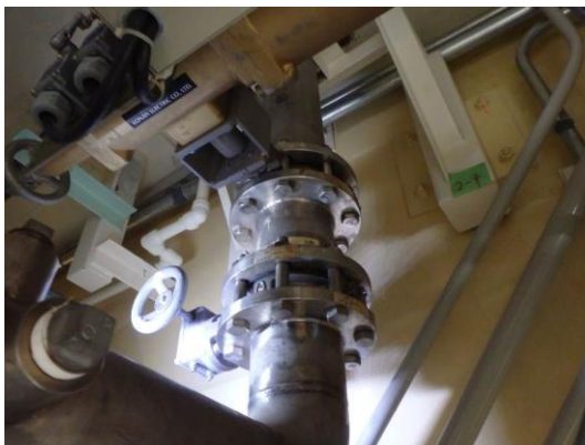
図 6.1-20 炉室(S)換気空調設備系統分離前及び分離後
