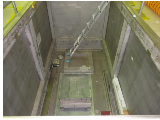
図 6.1-1 600φ 非均質炉心タンク撤去前及び撤去後
