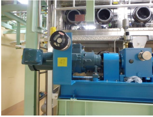
図 6.1-14 低速給液ポンプ A 撤去前及び撤去後
