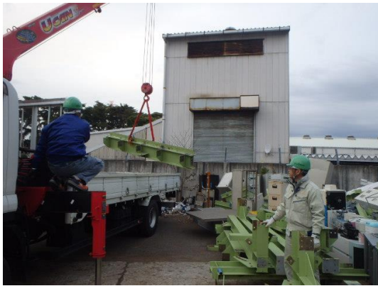
図 6.5-15 不用品及び撤去物の処理
