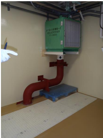
図 6.1-26 実験棟 A 建家換気空調装置（給気フィルタ）分離前及び分離後
