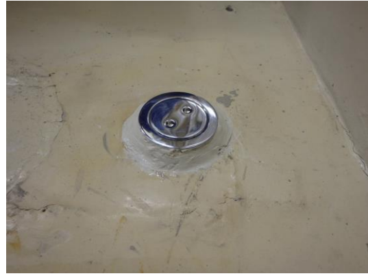
図 6.5-18 撤去後補修（ドレン口跡閉止）
