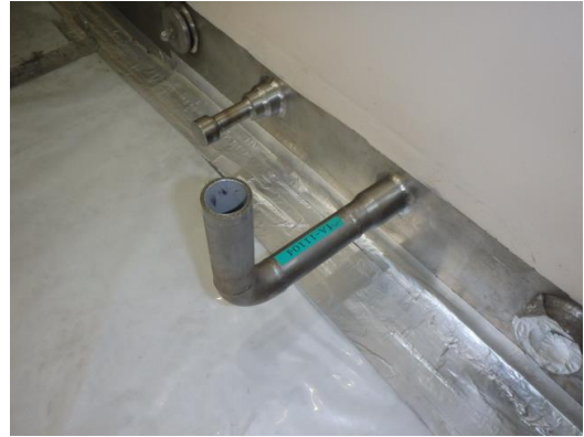
図 6.1-22 その他の設備（計装用空気系統(IA)）分離前及び分離後
