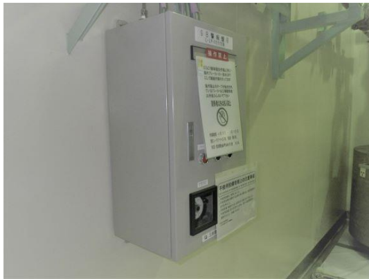
図 6.1-8 GB 警報盤 B 撤去前及び撤去後
