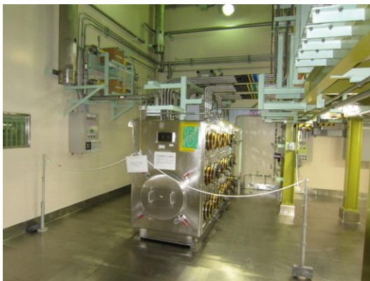
図 6.1-2 安全棒弁ボックス撤去前及び撤去後
