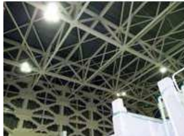
③原子炉建屋原子炉棟 3 階天井
