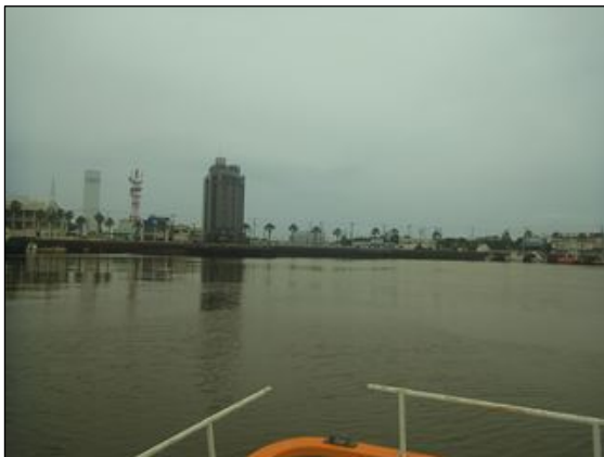
測点 C-P8 (木更津港内) 全景
