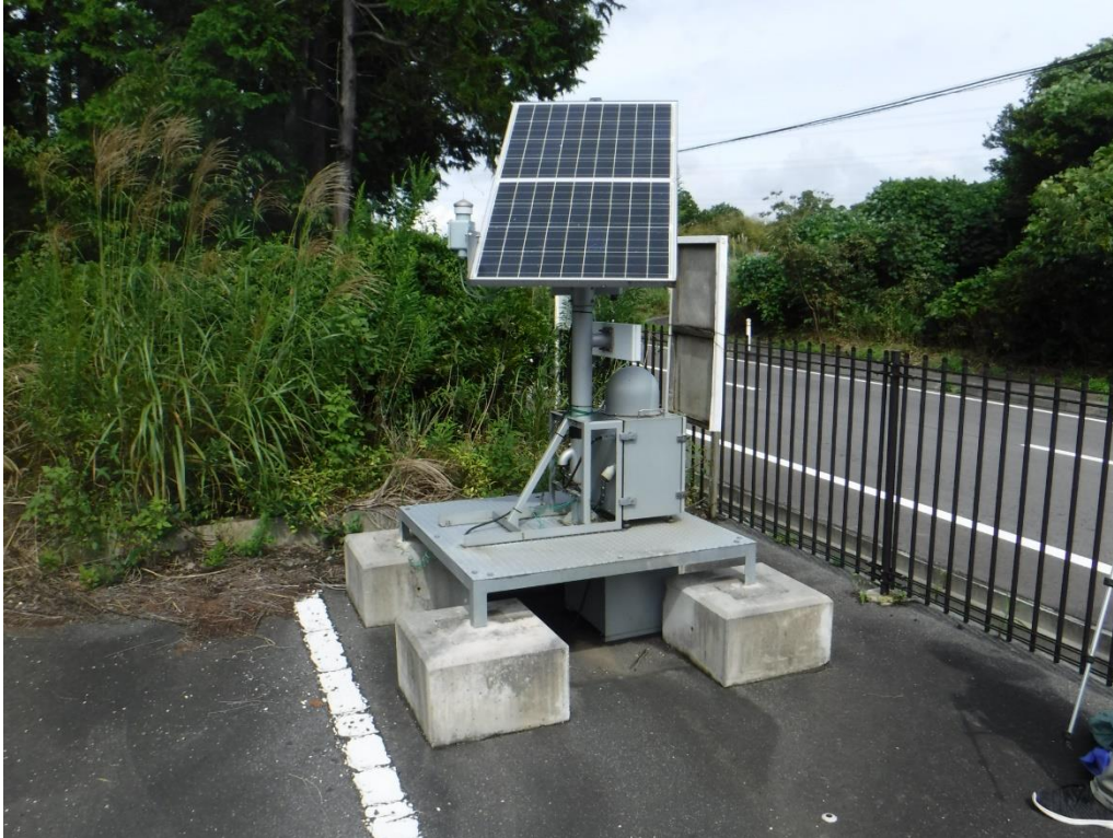
図 1 2 調査を行った大熊町に設置されている可搬型モニタリングポスト
