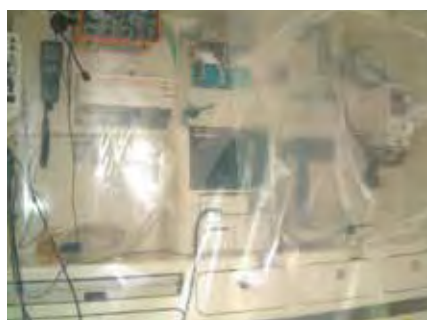
図5 モニター類の養生
