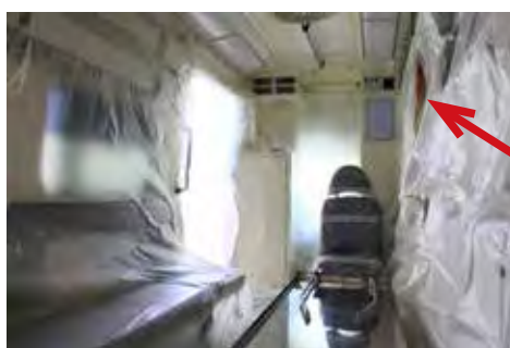
図5 モニター類の養生
