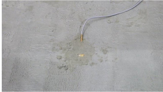
写真 A-4 ソイルモルタル層加速度計設置状況
