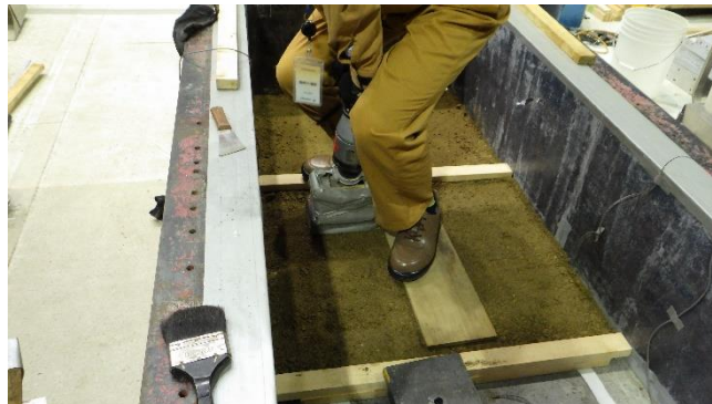
写真 A-5 礫質土層のバイブレータによる締め固め
