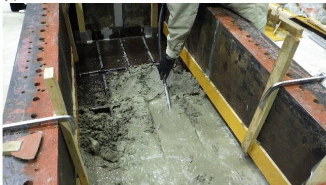
写真 A-2 ソイルモルタルの打設
