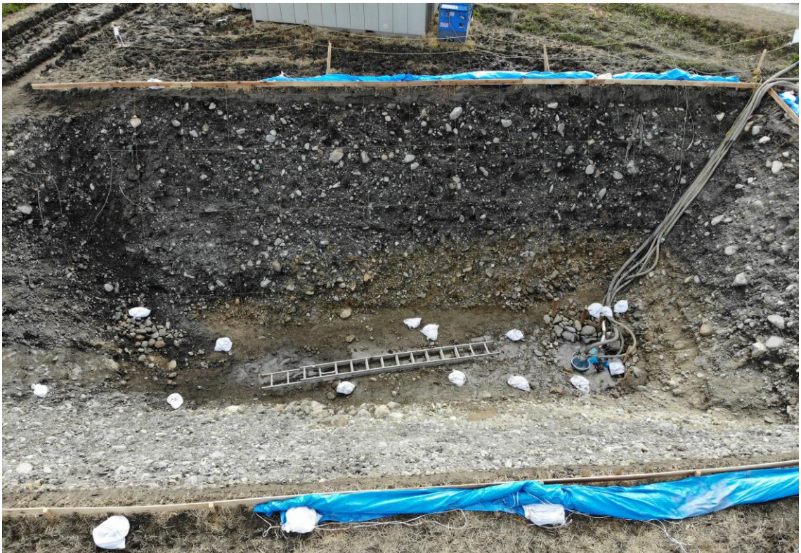
図 2-15 トレンチ全景写真 (3) 南面写真
