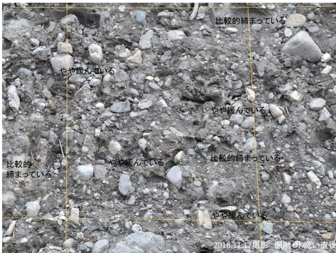
図 2-25 F1 断層（盛土中の緩み）
