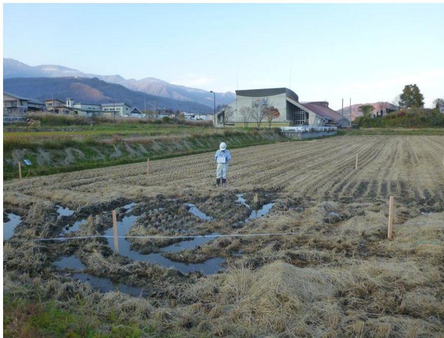
図 2-12 2018.11.8 掘削作業前 現地状況
