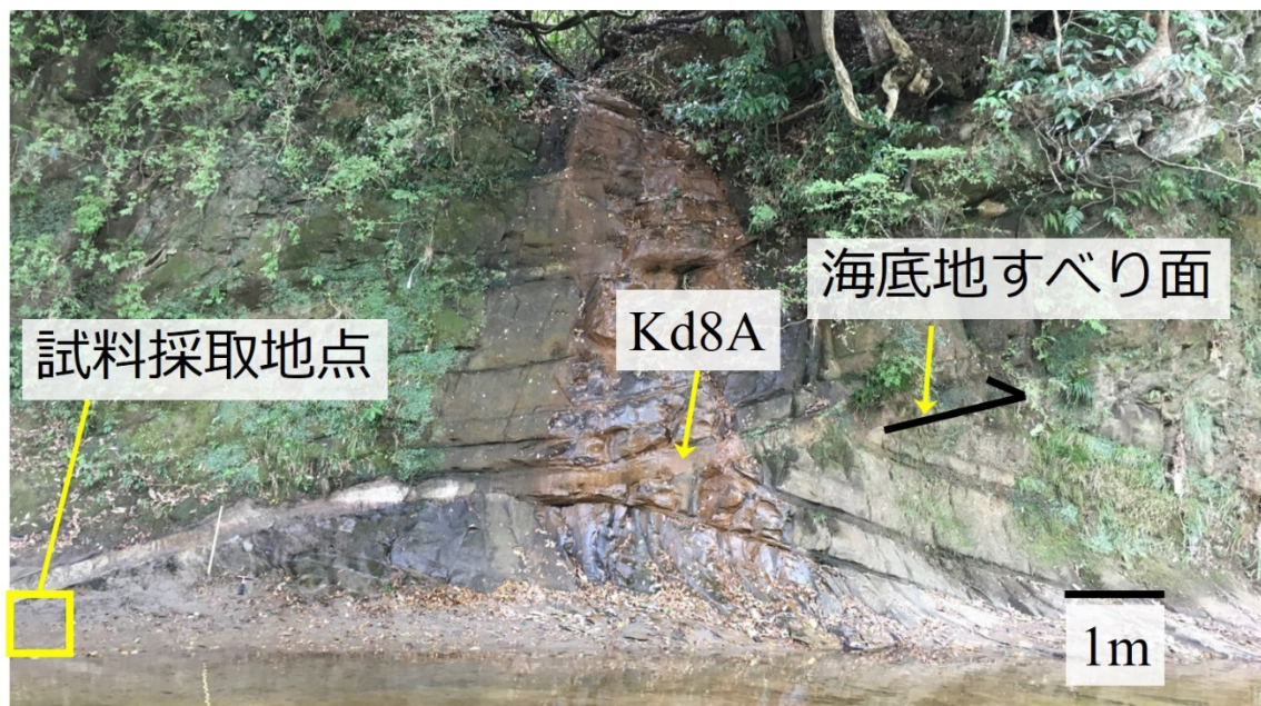
図 2.2.2-1 千葉県大多喜町の海底地すべり露頭と実験用試料採取地点。
