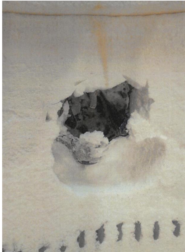
図 4.7-2 ヒーター線溶断部
