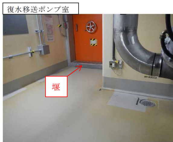
第 1-2 図：堰による拡大防止対策概要図
