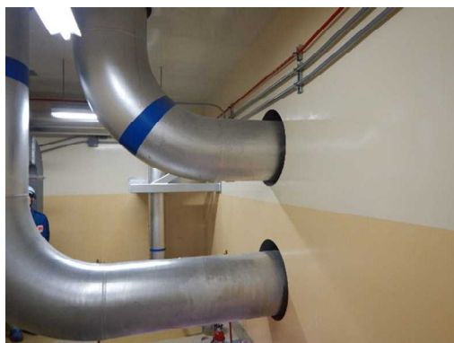
図 3. 貫通孔の隙間の例
