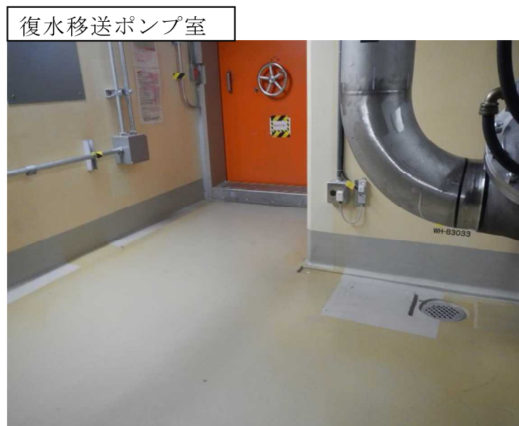
第 1-2 図：堰による拡大防止対策概要図
