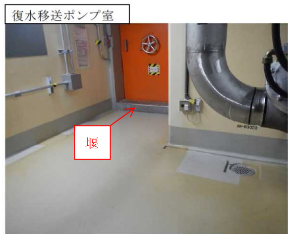
第 1-2 図：堰による拡大防止対策概要図
