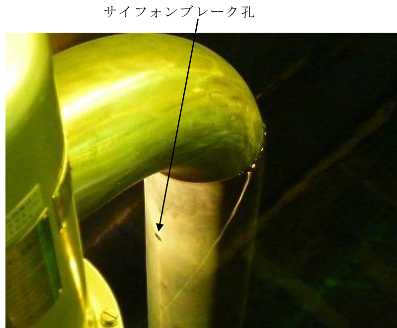
図 1-2 サイフォンブレイク孔の現場写真
