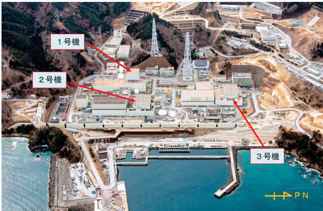
図 2-2 女川原子力発電所の全景
