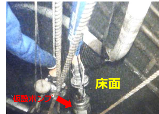
2号機T/B地下1階(最下階)の床面露出状況
