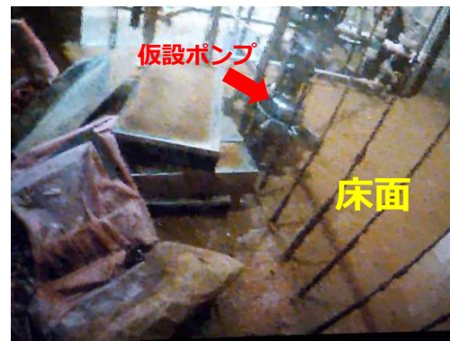
2号機Rw/B地下1階(最下階)の床面露出状況
