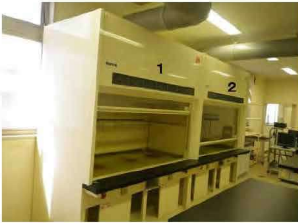
ドラフト1・2外観
