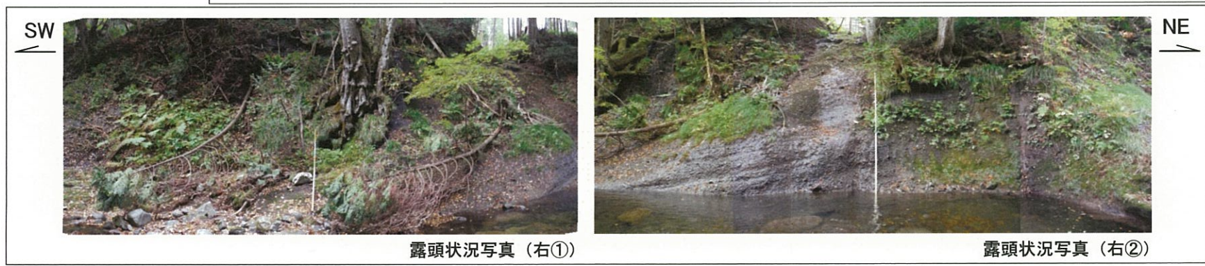
第3.3-59図(2) 六ヶ所村老部川(南)上流部の露頭状況図(リニアメント北方延長部)
