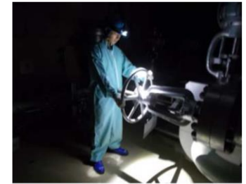
暗闇での 弁操作訓練
