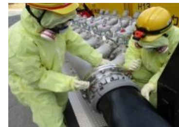
防護服着用での 注水ヘッダ接続訓練
