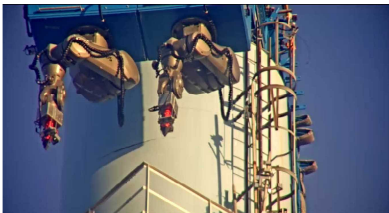
【写真①】筒身切断状況(9月18日)
