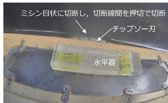
【写真②】筒身切断(マシン切)状況 (9月25日)
