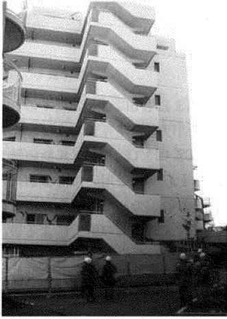
(被災建屋全景)
