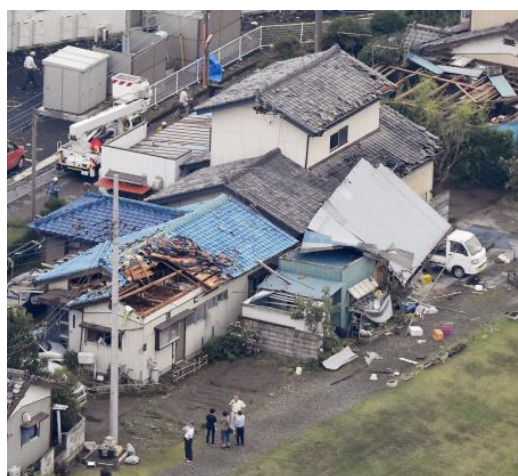
(a)住宅被害 4.6.1)
