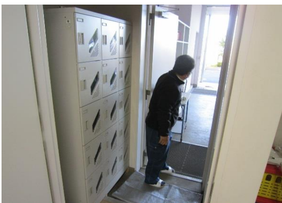
ガレージから除染室への通用口
