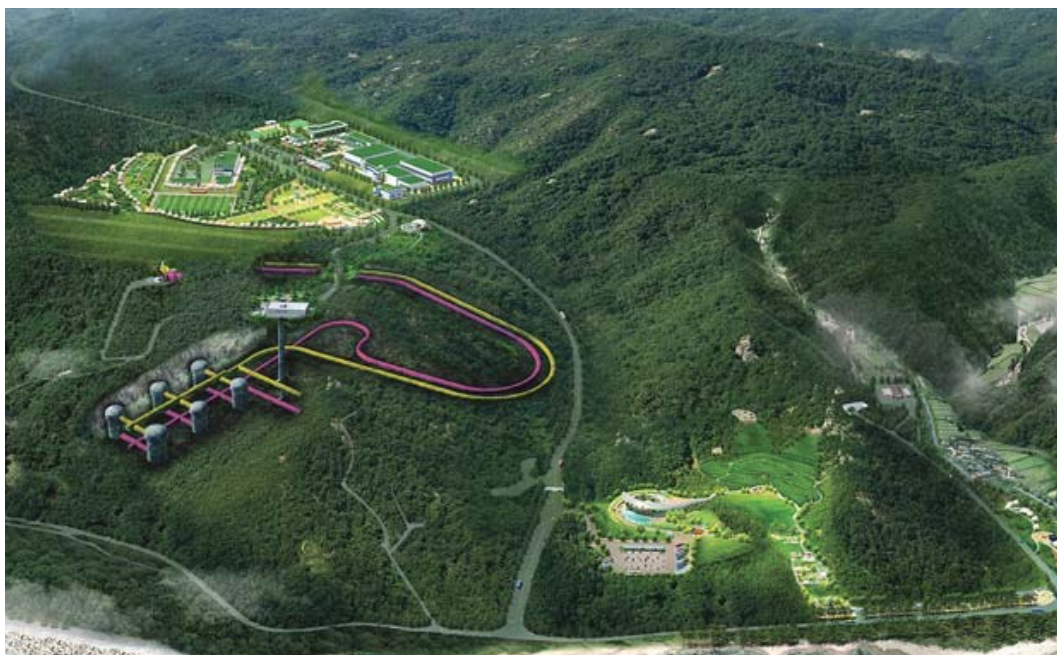
月城低中レベル放射性廃棄物処分センター 第1段階 地下空洞処分施設（概念図）
