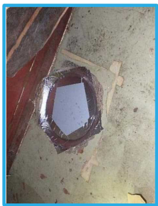
閉止措置を実施した排水枡 (NWF-424) の様子
