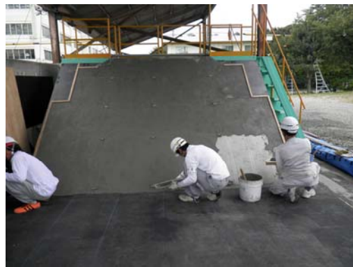
(d) モルタル打設
