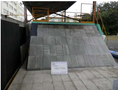
(c) コンクリート板敷設
