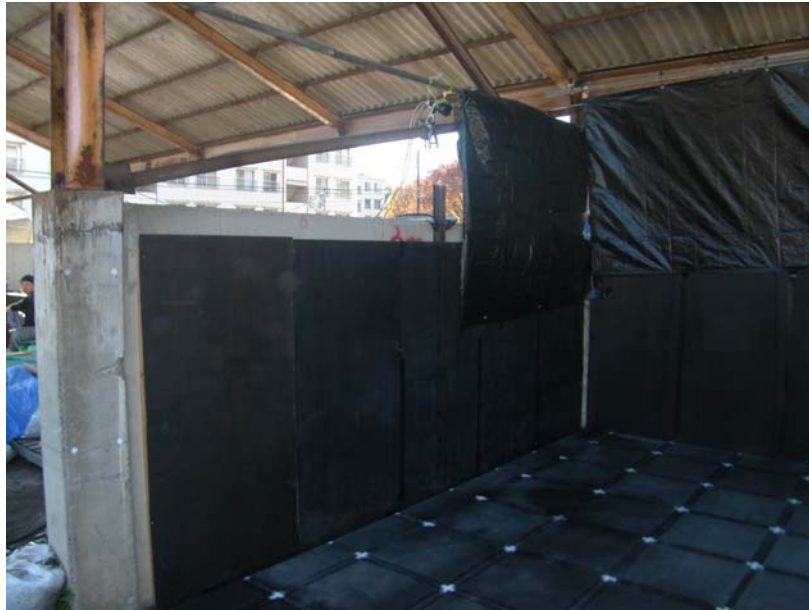
図 3.2.8 正面位置のカメラ設置状況
