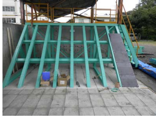
(b) 下地鉄板敷設
