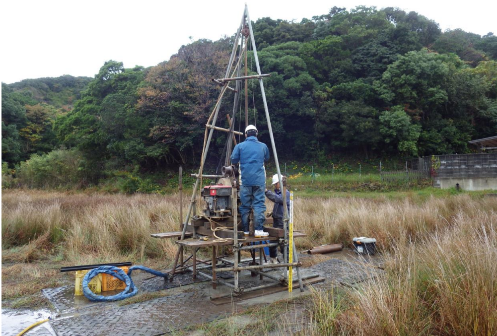
図 2-3-3 : 試料掘削風景.
