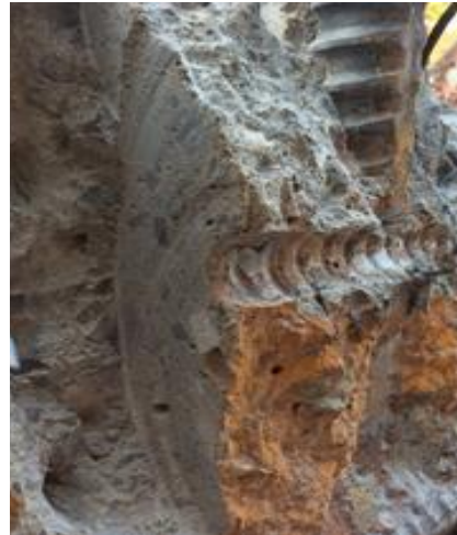
(b) コアコンクリートカット面
