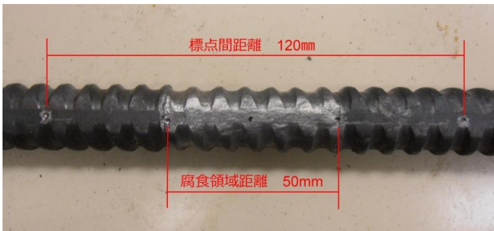
図 2.4.2-7 標点作製状況
