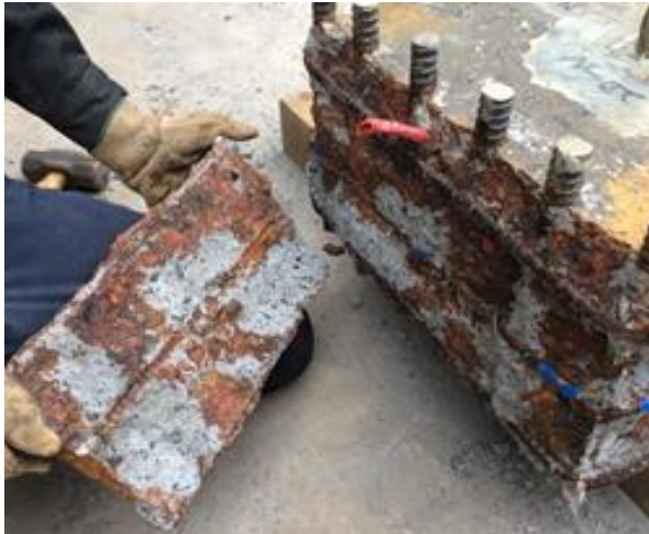
(a) かぶりコンクリート部
