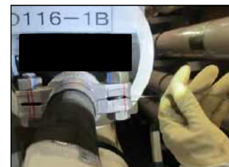
【仮復旧後】隙間確認
