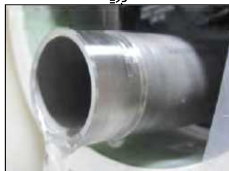
配管シール面外観確認
