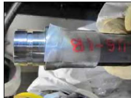
配管シール面外観確認
