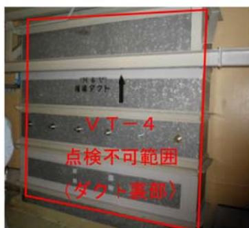
干渉物裏（ダクト裏）
