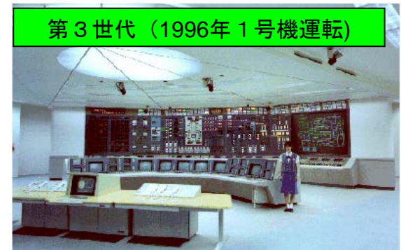
デジタル技術適用範囲を拡大 タッチ操作、大型スクリーンを採用
