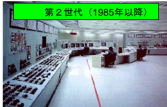
CRT上に系統図、パラメータのデジタル表示、トレンド表示などプラントの運転状態をより理解しやすいようなインターフェース機能を導入
