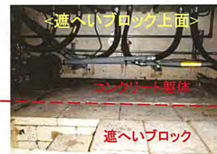
現場状況写真
