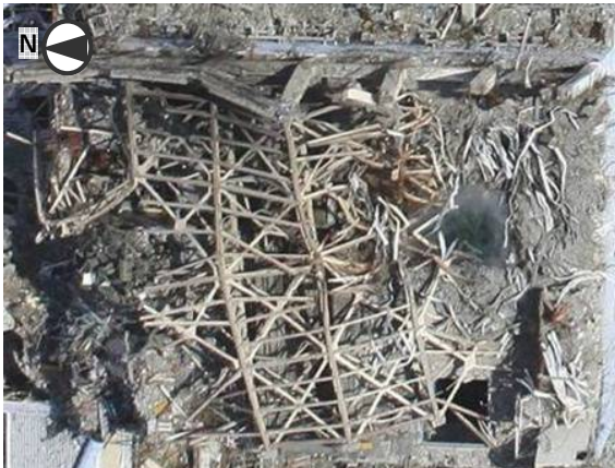
図-1 オペレーティングフロア状況 (平成23年3月24日撮影)
