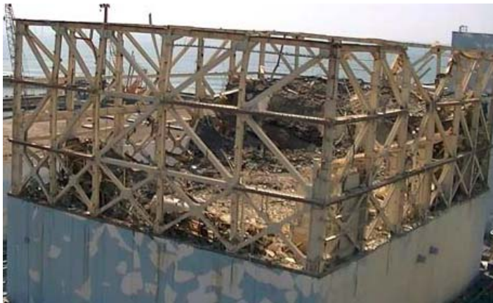
オペフロ全景（北西面）
