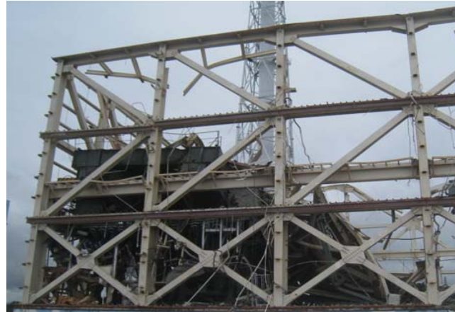
オペフロ全景（南東面）
