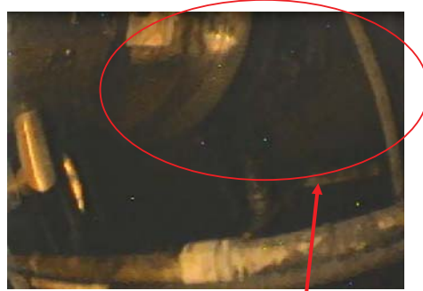
主蒸気配管C伸縮継手周辺
